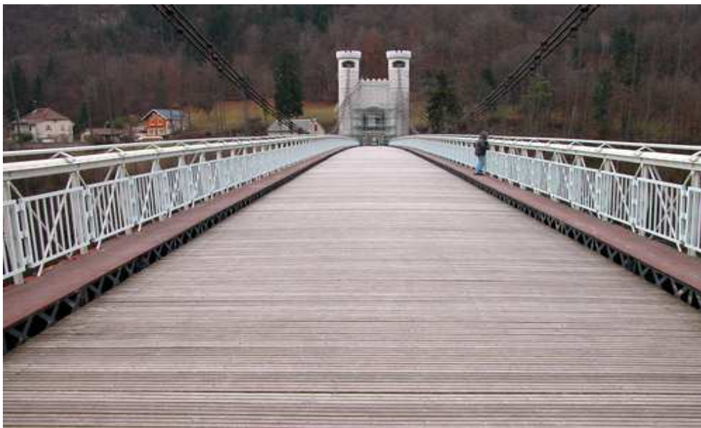
Ponte de la Caille
